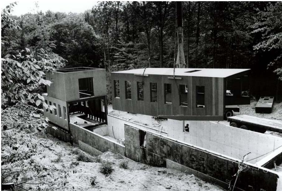
Figura 2: Fase de montaje de la casa con los grandes bloques de acero. 1991
