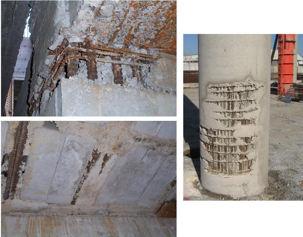
Fig. 5-1. Incorrecto hormigonado debido al exceso de armadura
