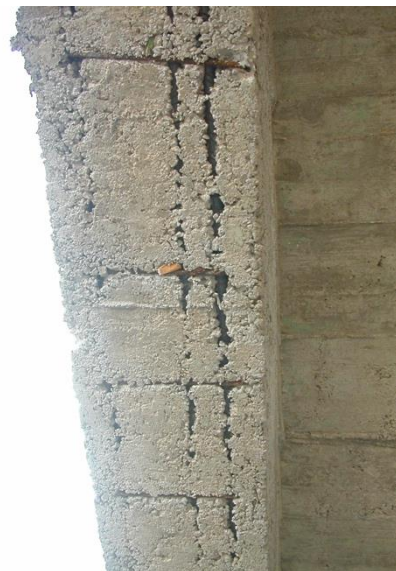
Figura 26a. Patologías por incumplimiento de recubrimientos
