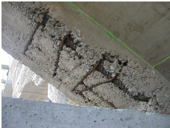
Figura 26a. Patologías por incumplimiento de recubrimientos
