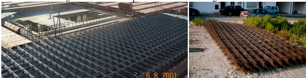
Figura 14. Acopio de mallas electrosoldadas en obra
