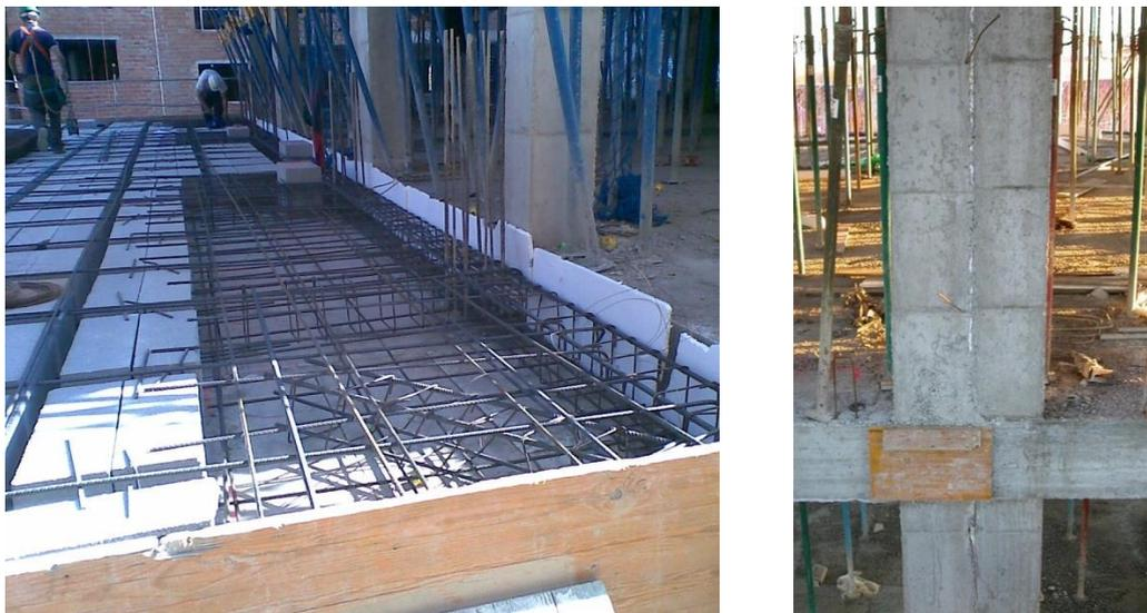
Figura 14. Junta estructural para evitar longitudes superiores a  $40 \pm 10$  metro
