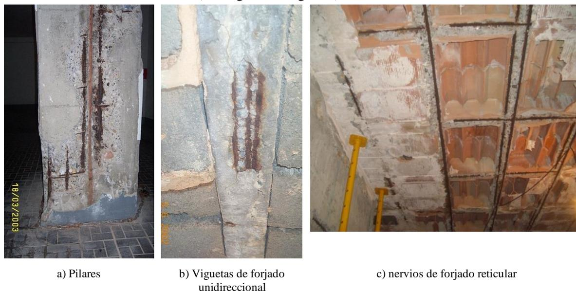
Figura 1. Degradación por corrosión de las armaduras
