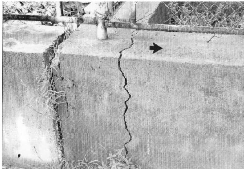
Figura 10. Fisura de retracción en una valla de hormigón en masa, consecuencia de la coacción existente en sus extremos
