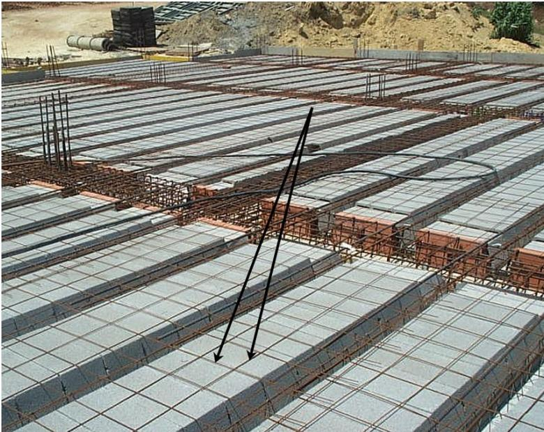
Figura 16. Armadura de reparto en la capa de compresión de forjados
