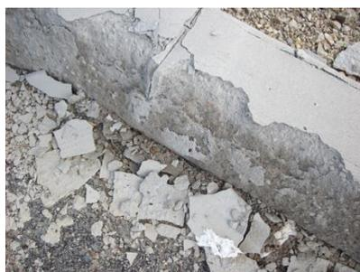
Figura 3. Degradación del hormigón por heladas
