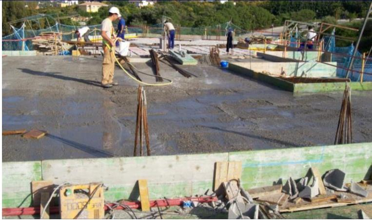
Figura 13. Curado mediante riego directo durante el fraguado y primer período de endurecimiento del hormigón.
