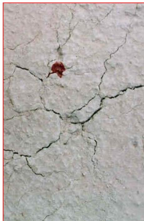
Figura 8. Fisuras de retracción
