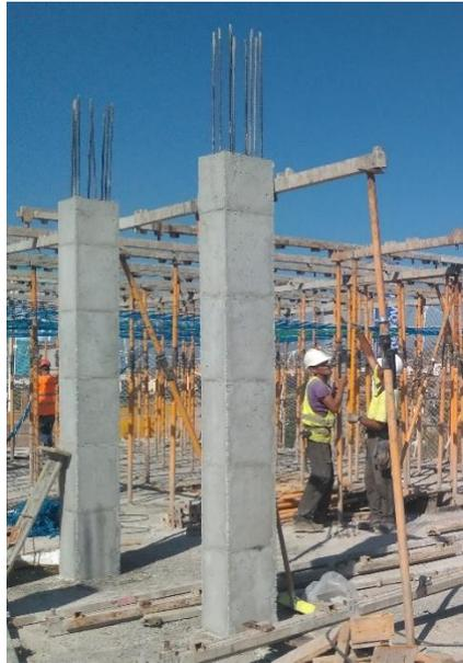
Figura 18. Pilares de hormigón de la estructura vertical
