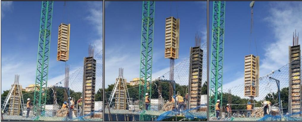
Figura 25. Fotografías de la tarea de encofrado de un pilar tomadas durante las observaciones realizadas en los trabajos de campo (Elaboración propia)
