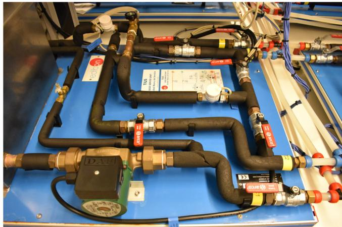
Figura 3.5: Válvulas dispuestas para flujo en paralelo.
