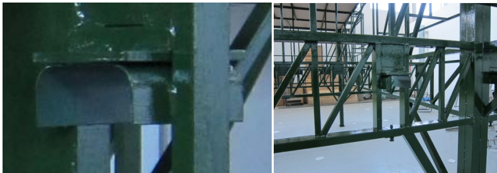
FIGURA 12. Pletinas de fijación de varal
