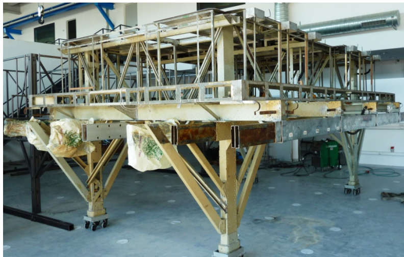
FIGURA 1. Estructura a sustituir
