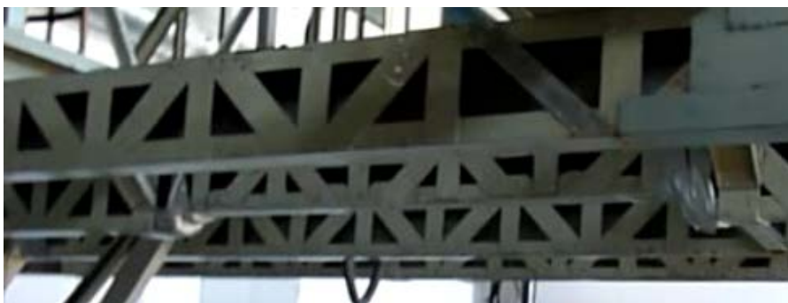
FIGURA 3. Arrastramiento de los perfiles de la zona inferior
