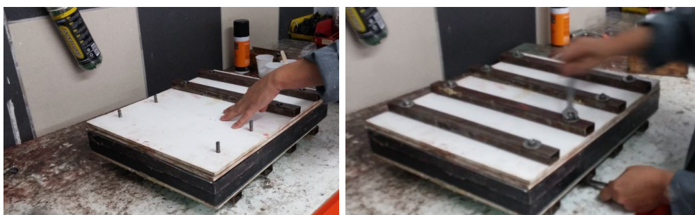
(e) Proceso de montaje de las barras de refuerzo. (f) Montaje de las barras de refuerzo.
