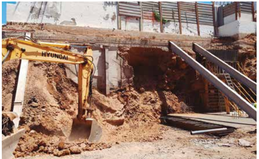
Apuntalamiento provisional de una medianera. Fotografía de Maximiliano Valero Padilla, 2020.
