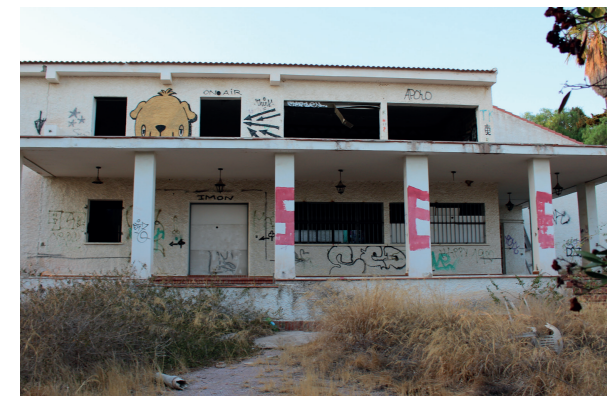
Fotografía desde la puerta principal. (2019).
