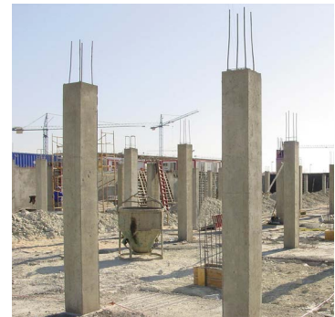
Fig. 23. Referencia estructura de hormigón
