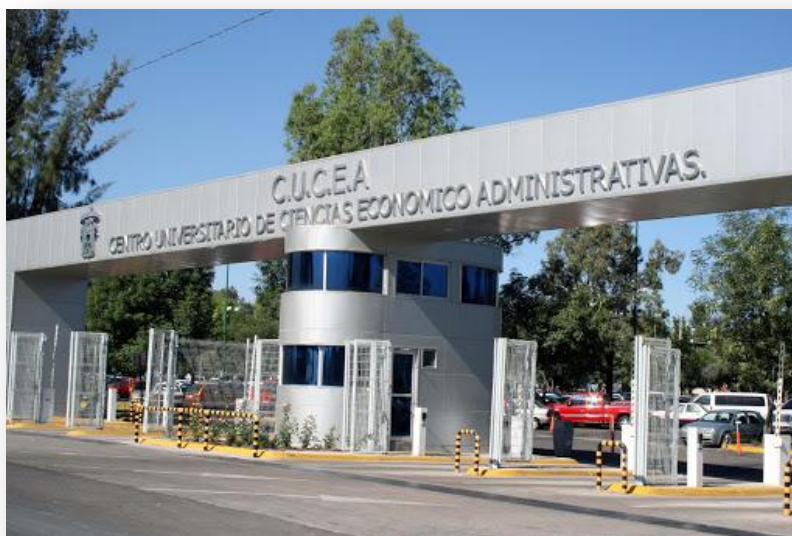
Figura 8. Udgvtv. (2019) Instalaciones CUCEA. Universidad de Guadalajara. [Figura]. Recuperado de: https://cutt.ly/FfnxNO8
