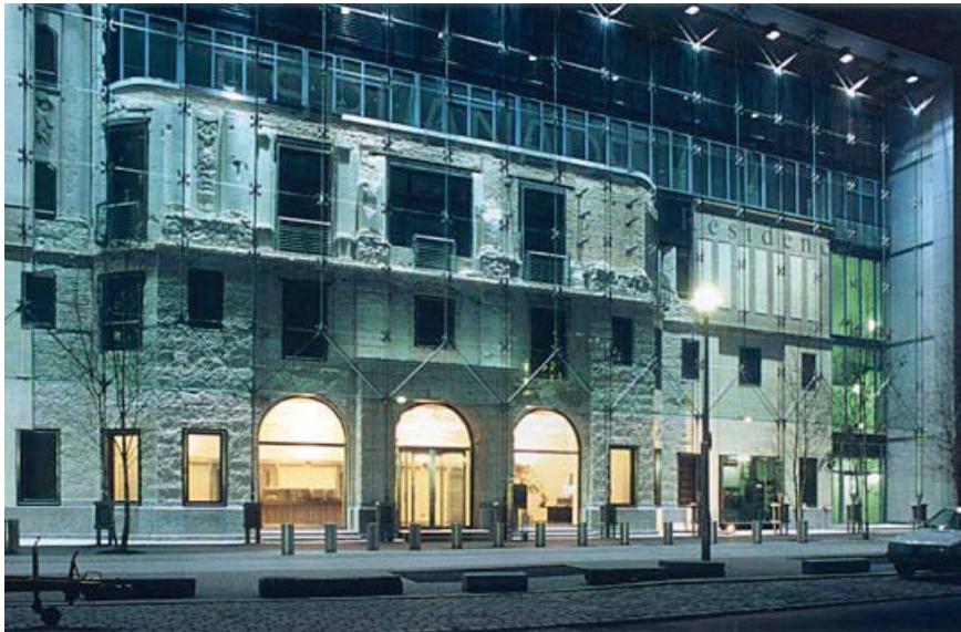
fig. V. Restos de la fachada del Hotel Esplanade a la calle Bellevuestrasse, insertados dentro del volumen acristalado del Sony Center.
