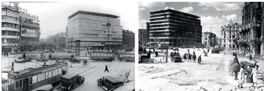
fig. V: Imagen del edificio de oficinas de Mendelsohn Columbus Haus en 1932 (izquierda) y en 1945 (derecha) tras los bombardeos.
