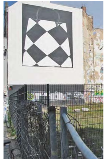
Medianeras en Berlín en vacío entre la calle Friedrichstrasse y Oranienburgerstrasse, 2012.
