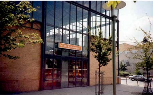
Imagen A: Estación del M-bahn Kemperplatz
