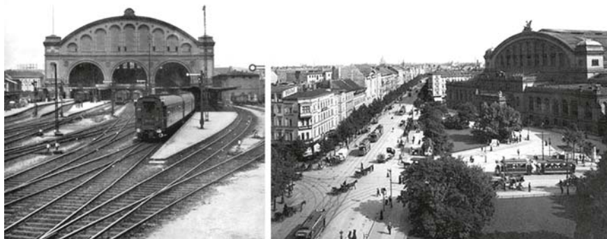
fig. V a: Fotorafía de la estación Anhalter en la parte de las vías. fig V b: Fotografía de la fachada principal y plaza de acceso a la estación Anhalter , 1910.
