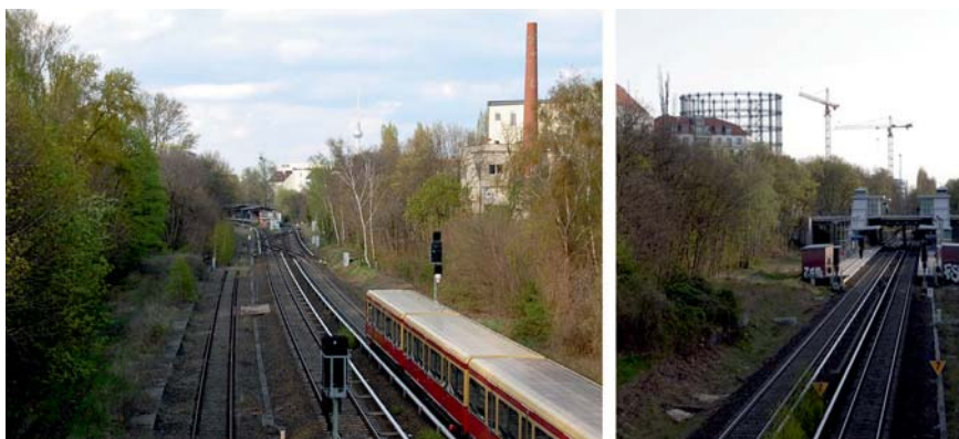
fig.1: Imágenes de la línea de S-bahn a su paso bajo el Langenscheidtbrücke.
