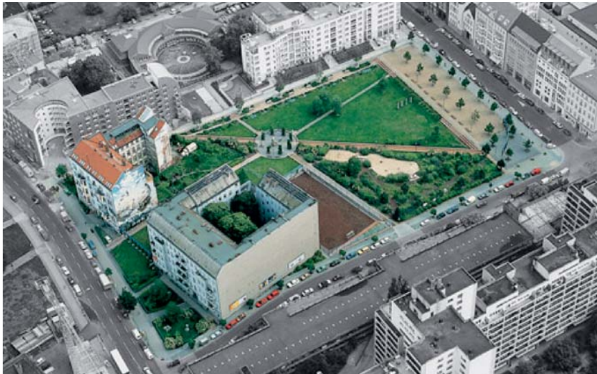
fig.VII: Vista aérea del aspecto actual del vacío del circo. En ella podemos distinguir, en la parte de abajo de la fotografía, el edificio que enmarca el primer plano de la carpa que aparece en la película, y frente a él la fachada que oculta la gran medianera que hacía de fondo en esta escena. También observamos a la izquierda de la imagen dos edificios que muestran sus medianeras ciegas con un aspecto muy similar al que tuvieron en 1987.
