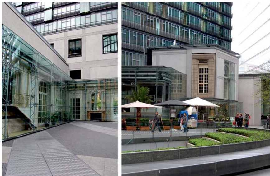
fig. VII: En las imágenes de 2012 podemos observar cómo han quedado los restos de lo que fue el hotel Esplanade, ahora insertados de manera artificiosa en el nuevo edificio. El salón de baile Palmenhof (izquierda) se ha conservado y se han incorporado a la plaza interior del Sony Center, protegido con una lámina de vidrio, que le aporta un aspecto de imagen congelada en el tiempo. Un alzado interior de la estancia contigua - incluyendo la chimenea y los espejos del salón- se exhibe ahora convertido en escaparate turístico. En la imagen de la derecha vemos la Kaisersaal desplazada de su posición original. Ambos salones forman parte del restaurante Kaisersaal. A la izquierda del salón del Emperador, un volumen de vidrio alberga una estancia del nuevo Café Josty construida a partir de los fragmentos de la sala de desayunos del hotel.
