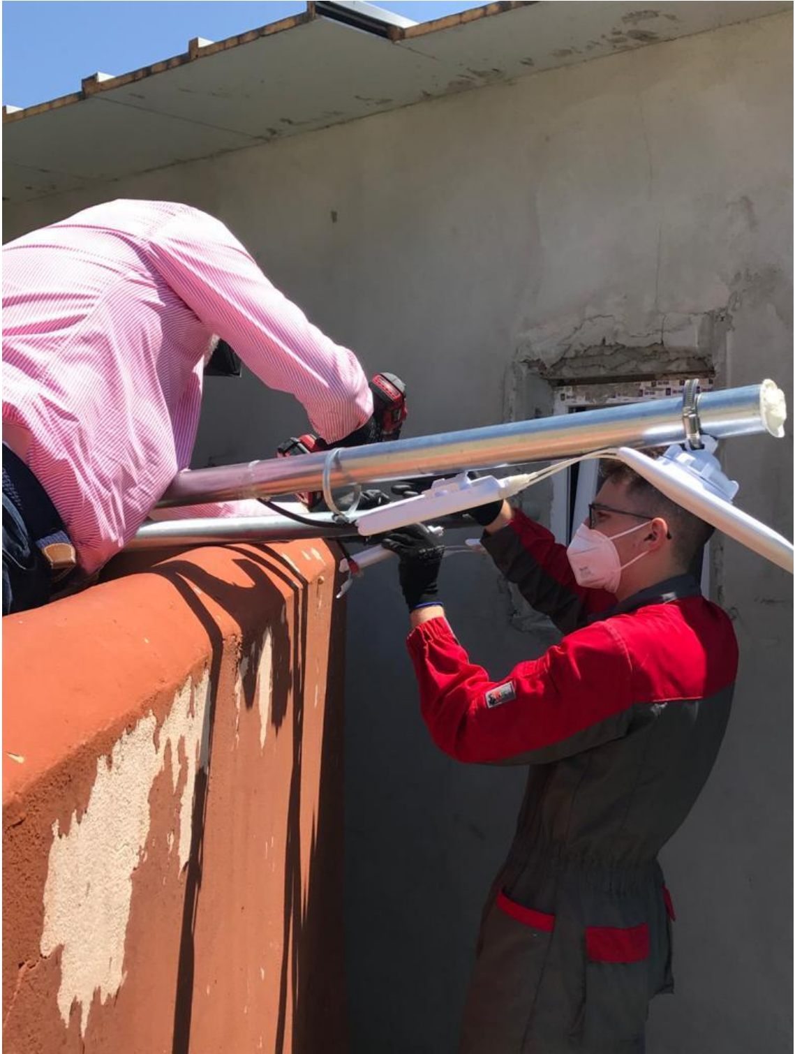
Figura 12. Fotografía del equipo trabajando en la instalación de antenas
