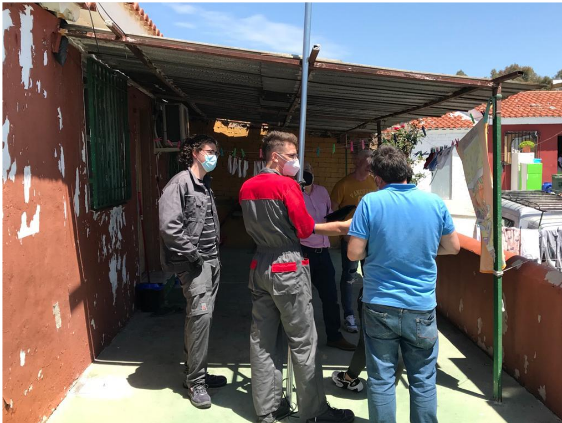
Figura 13. Fotografía del equipo colocando una antena
