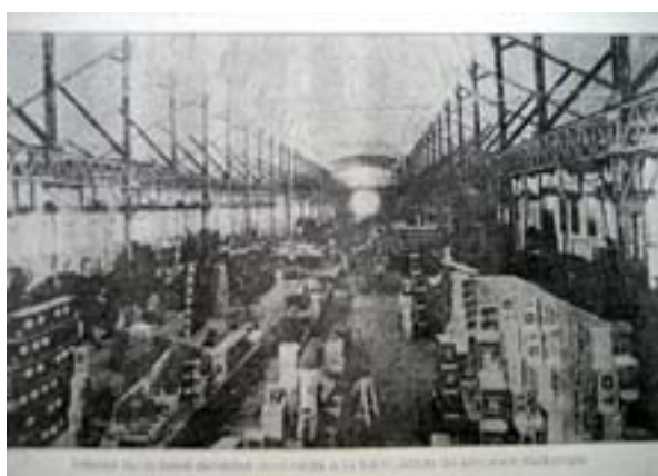
Instalaciones en los talleres Lapeira
