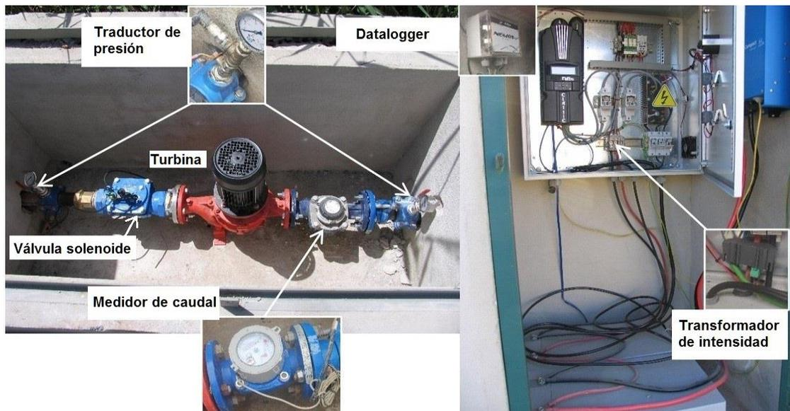
**Figura 29. Ubicación del sistema experimental: Válvula reductora abajo a la izquierda, ERT arriba a la izquierda y panel de almacenamiento y control energía a la derecha**
