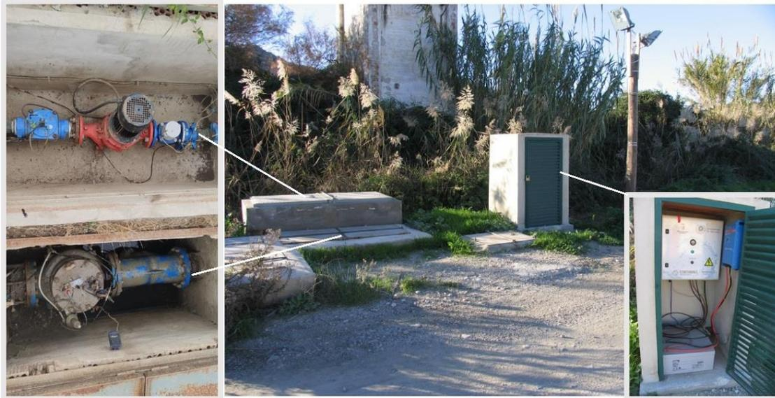
**Figura 28. Ubicación del sistema experimental: Válvula reductora abajo a la izquierda, ERT arriba a la izquierda y panel de almacenamiento y control energía a la derecha**
