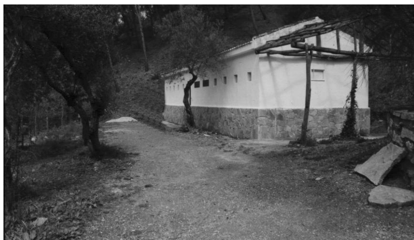
Ejemplo de infraestructura en un Área de Acampada (Torrijos, Montes de Málaga, 2002)
