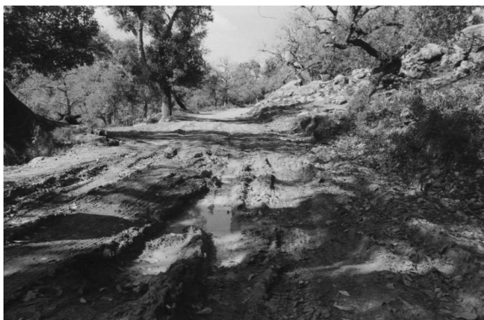
Ejemplo de firme con textura arcillosa muy impactado por el pisoteo (escasa permeabilidad y facilidad de encharcamiento) (Los Alcornocales, Málaga, Febrero, 2002)
