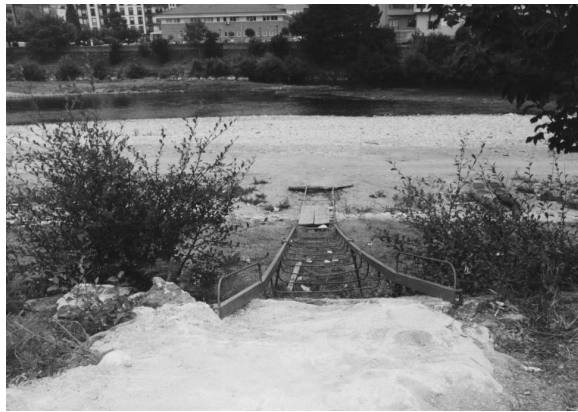
Rampas construidas en los márgenes del río Sella para la introducción de las canoas en la lámina de agua (Arriondas, Asturias, 2001)
