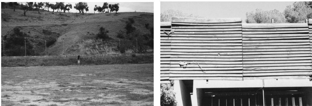
Ejemplo de cierre de seguridad en un campo de tiro con arco y de un parapeto de seguridad en un campo de tiro olímpico (campo de tiro El Francés, Málaga, 2001)
