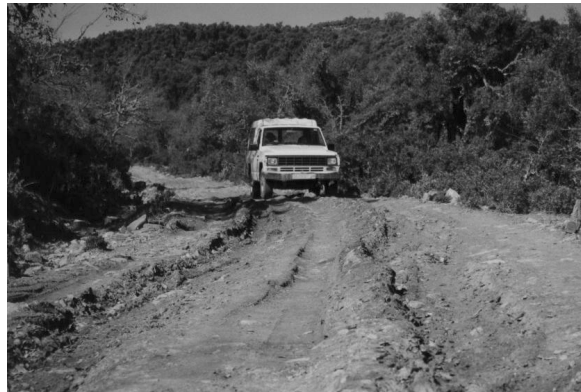
Ejemplo de la erosión provocada por el paso de vehículos todo terreno sobre un sustrato arcilloso (Parque Natural Alcornocales, Málaga, 2002)
