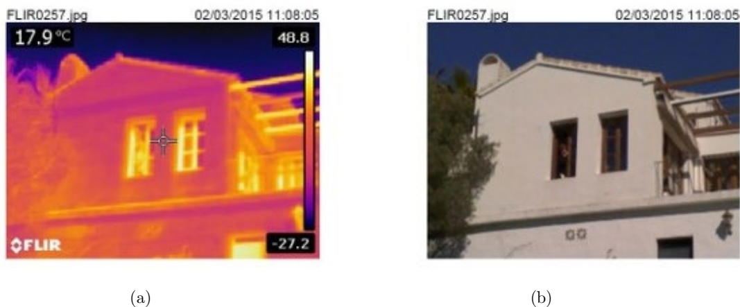
Fig. 4.2 (a) Ejemplo de fotografía termográfica de la villa. (b) Misma fotografía en luz visible
