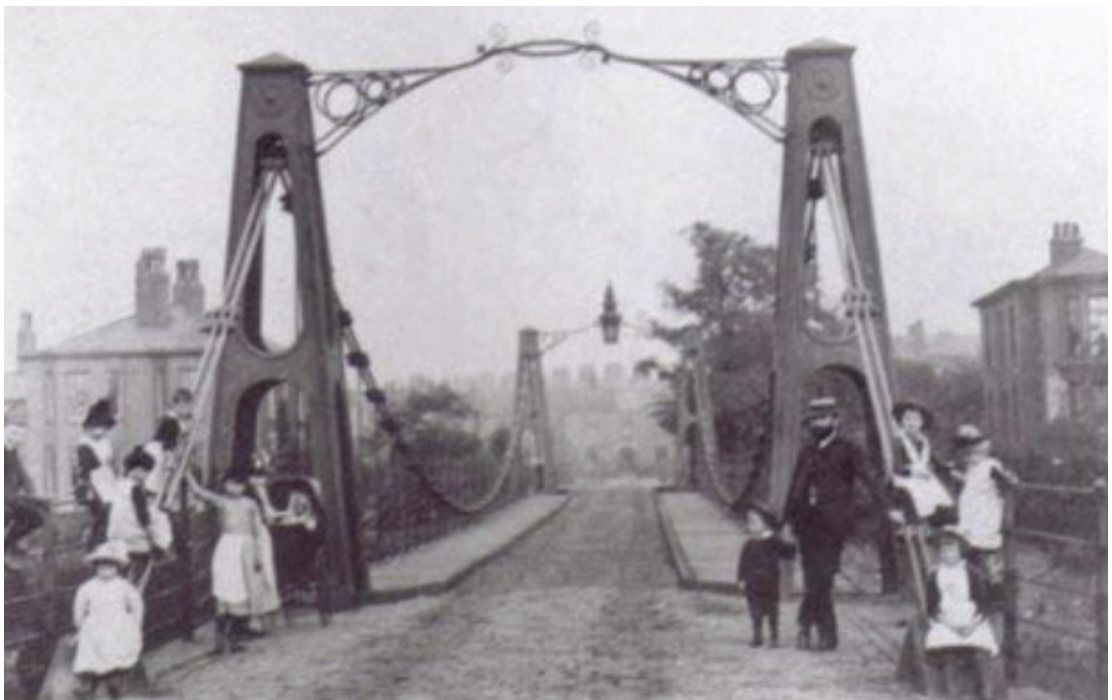
Figura 17: Puente de Broughton
