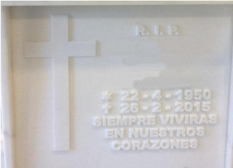
Figura 18. Fondo picado, abujardado y después alisado o lijado y abrillantado. Empresa funeraria La Esperanza. (elab. propia)
