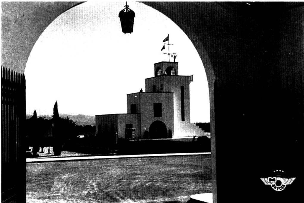
Instalaciones y jardín del Aeródromo de Málaga. 27-02-46
