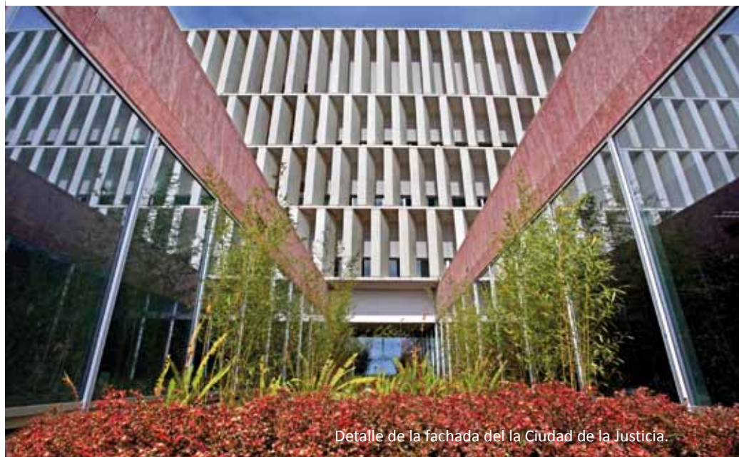
Ciudad de la Justicia de Málaga, diseñada por el arquitecto José Seguí e inaugurada en 2007.
