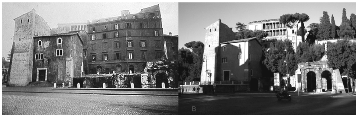
Lám. 46. Roma, cassetta medieval en la zona adyacente al Teatro Marcello, A) Antes de su aislamiento, 1937. B) En la actualidad.
