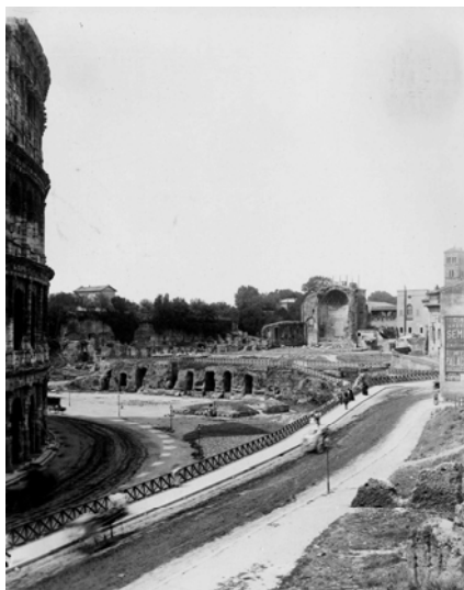
Lám. 52. Roma, Fotografía de la via de acceso al Colosseo y restos del Tempio di Venere y base del Colosso di Nerone , 1901.
