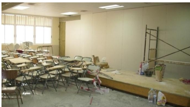
Fig.6.9. Adecuaciones aulas Gerald Brenan. Archivo propio. 2010.
