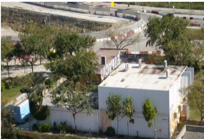
Fig.5.42. Vista lateral del ESPACIU (contenedores). Archivo Propio. 2010.
