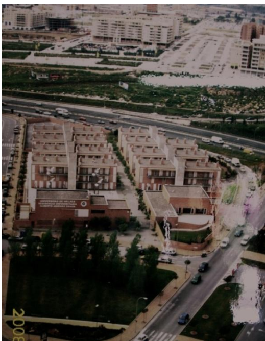
Fig.4.14. Residencia Alberto Jiménez Fraud. Fotografía expuesta en Vicerrectorado de Infraestructura. 2009.
