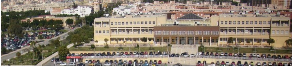
Fig.6.64. Parte Frontal de la Facultad de Derecho. Archivo propio. 2010.
