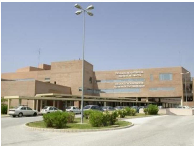
Fig.5.20. Escuela Técnica Superior de Ingeniería y Telecomunicación. http://www.infouma.uma.es
