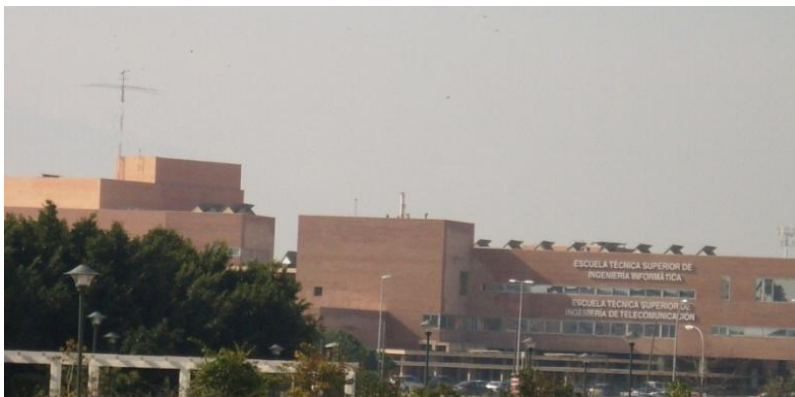
Fig.6.40. E.T.S Ingeniería Informática y Telecomunicación. Archivo propio. 2011.
