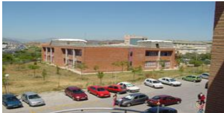
Fig.6.130. Trincheras sobre el Aulario Severo Ochoa. Archivo propio. 2011.
