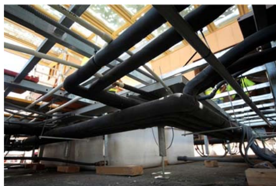
Figura 7: Canalización de las tuberías en el perímetro del patio y acceso a un módulo
