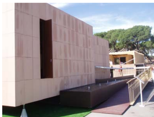
Figura 5: Imagen del estanque evaporativo en la fachada norte de acceso al patio.
