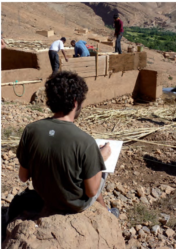
Proceso constructivo con tapiales. Autor: José Manuel López Osorio
