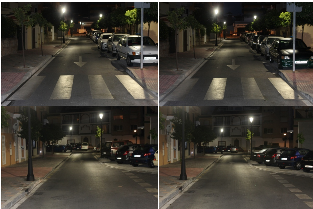
Vial sin reducción de tensión Vial con tensión reducida
