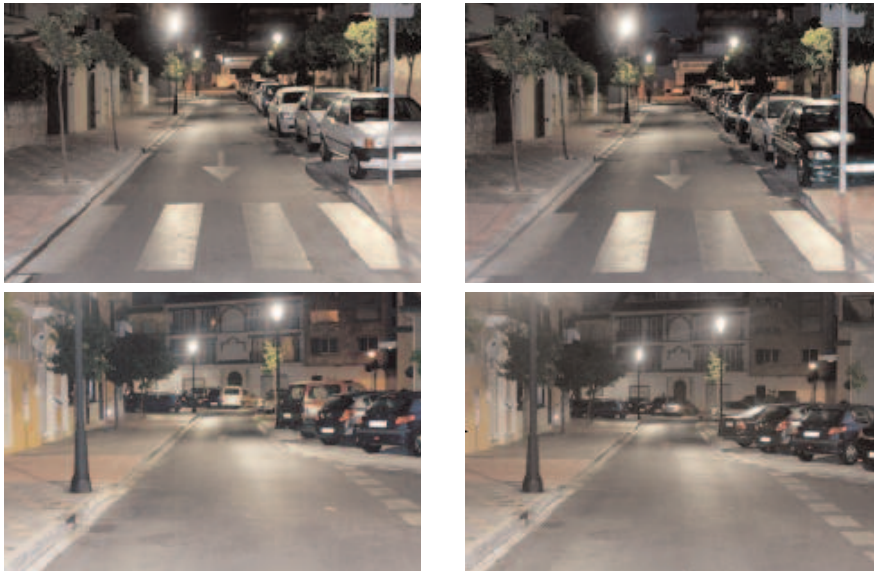
Figura 14. Vial sin reducción de tensión y vial con tensión reducida al 20%. Fotografía del vial antes y después de reducir la tensión en cabecera del cuadro. Aparentemente no se observan diferencias en los niveles de iluminación ni en el color.
