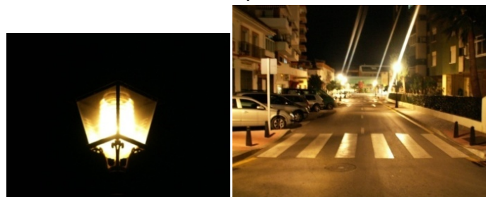
Fig. 11. Fotografía del vial y detalle de lámpara de HM de 150 W.
