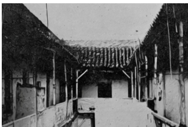
Imagen 16: Vistas desde la planta de arriba de un Corralón
