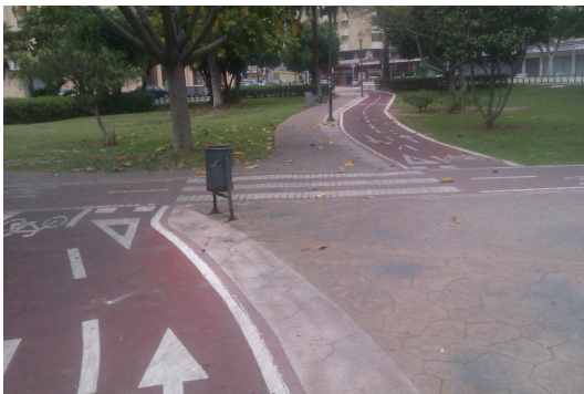
Imagen 9 y 10. Curva innecesaria. Fuente: Elaboración propia.
