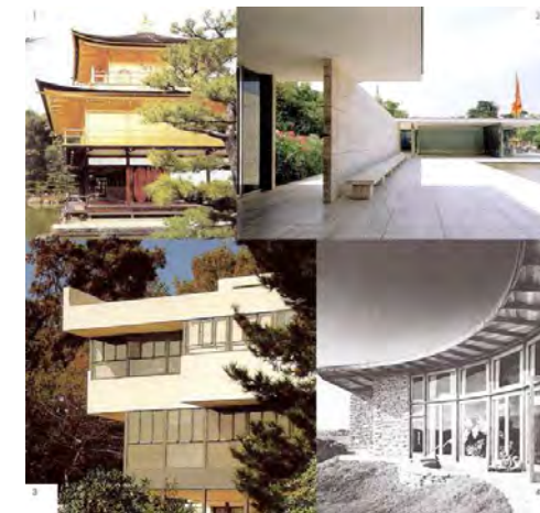
Figura 101: Elementos arquitectónicos de protección solar. Sup. Izq.: Pabellón de Oro (Kitoto). Sup. Dcha.: Pabellón de Barcelona. Inf. Izq.: Health House (Los Ángeles). Inf. Dcha.: Casa solar. Fuentes: Sup. Izq.: http://sobre-japon.com/2009/10/11/el-famoso-pabellon-dorado-de-kioto/ . Sup. Dcha.: http://revisiointerior.blogspot.com.br/2010/02/pabellon-barcelona.html . Inf. Izq.: http://www.neutra.org/tours.html . Inf. Dcha.: http://arkinetia.com/articulos/ken-shuttleworth-make-architects-reino-unido_a137
