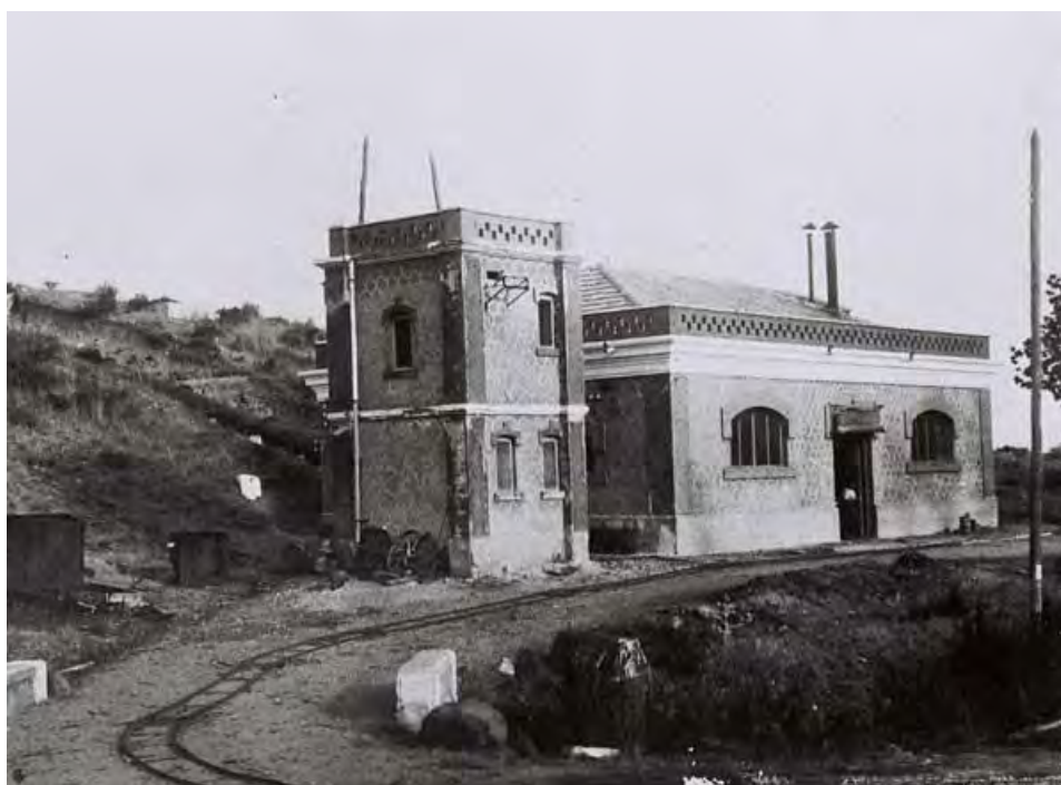
FIGURA 25 FÁBRICA DE ELECTRICIDAD. COMIENZOS DEL SIGLO XX
