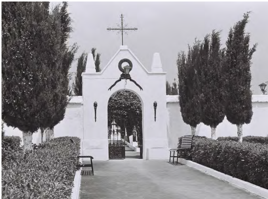
FIGURA 23 ENTRADA DEL CEMENTERIO
